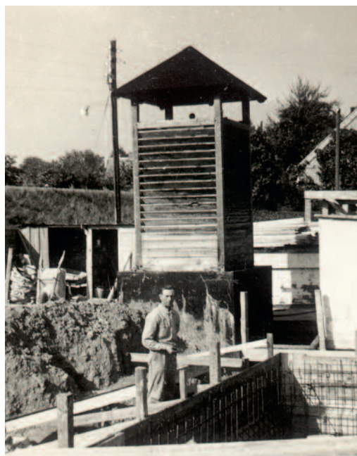
Vandværksbygningen under opførelse i 1962 – bemærk »vandtårnet« midt i billedet. Vandtårnet og dele af det gamle vandværk bliver siden nedrevet.
